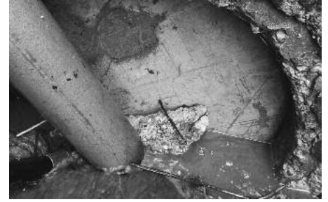
Die kreisrunde Metallplatte wurde von Unbekannten in den Rohrdurchlass gestellt.
