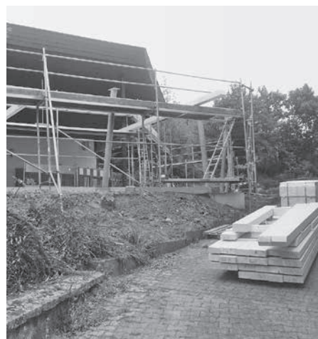
Beginn der Arbeiten
