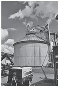
Im Faulturm der Verbandskläranlage in Frauenzimmern musste geputzt werden. Der Faulschlamm im Turm wird einmal im Monat umgewälzt und Teile davon ausgepresst und weggefahren.
