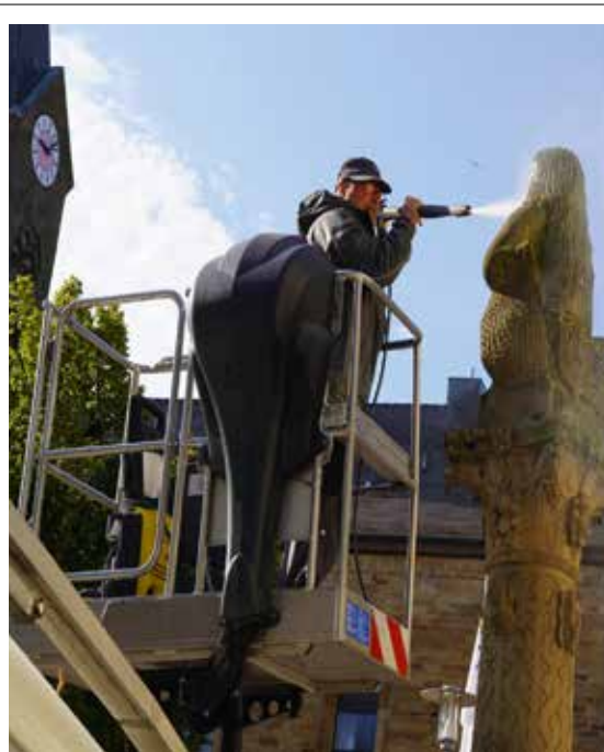
Güglinger Marktbrunnen wird restauriert Steinmetzmeister Wütherich mit Dampfstrahler und Meißel
