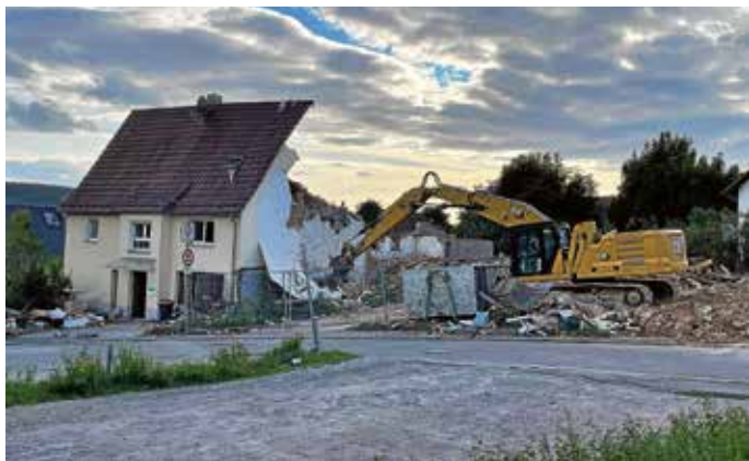
Schafhausplatz wird zur Bebauung vorbereitet
