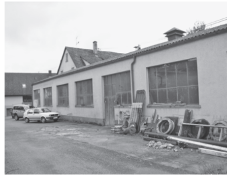
Östliche Halle Bauhof
